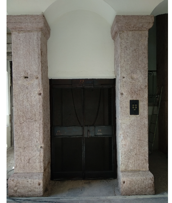
VISTA - A - PORTA ASCENSORE DA CONSERVARE E CRISIERE SUL RETRO CON PANNELLO IN CARTONGESSO
